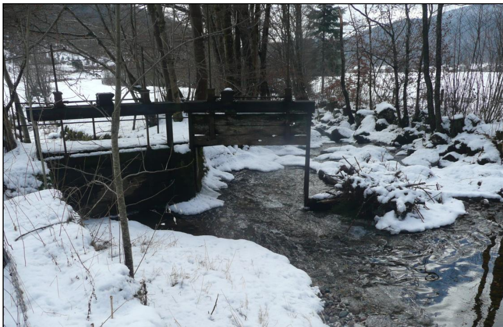
Prise d'eau du canal de la Mouline (vanne fermée rive gauche)
