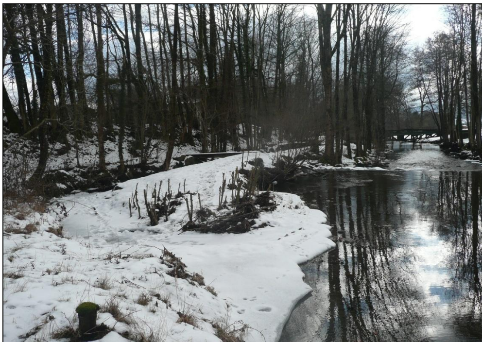
Prise d'eau du canal du Moulin à Farine. Vanne au second plan (fermée lors de notre visite)
