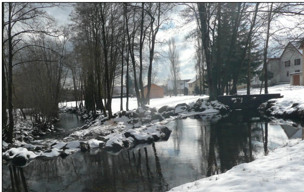
Barrage sur la Savoureuse et vannes de prise d'eau du canal des 3 Moulins à Chaux
