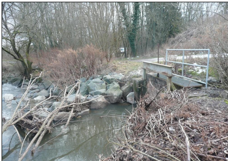
Ouvrage de prise d'eau du canal de Chatenois les Forges
