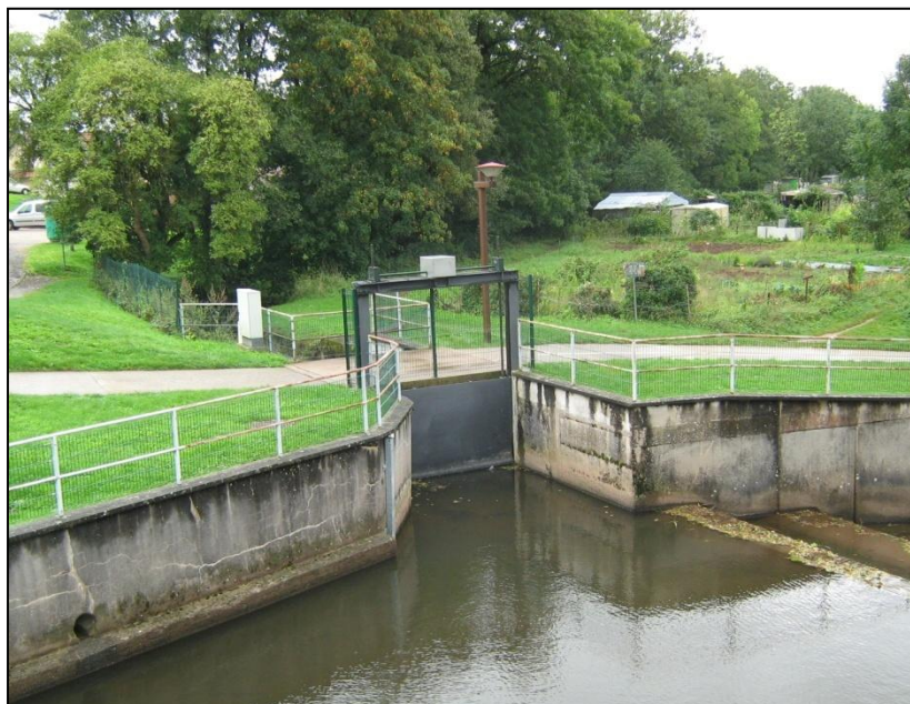
Prise d'eau du canal du Martinet dans la Savoureuse
