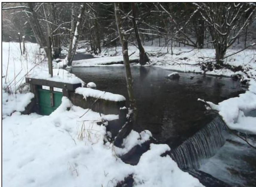
Vanne de prise d'eau du canal de Vescemont derrière un seuil en bois
