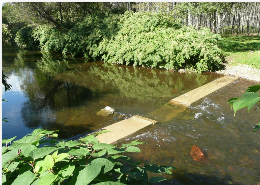
Photographie du seuil jaugeur sur la Savoureuse du champ captant de Sermamagny
